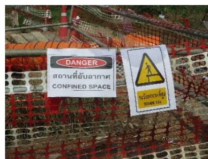
รูปที่ 2-37 การติดตั้งราวเหล็กราวเหล็กและป้ายเตือน บริเวณโดยรอบพื้นที่ดำเนินการ Tie-in
