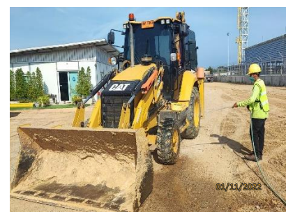
รูปที่ 2-9 พนักงานทำความสะอาดเศษวัสดุหรือดินที่ร่วงหล่นบนถนน และล้อรถที่มีเศษดินโคลนติด ก่อนออกจากพื้นที่ก่อสร้าง
