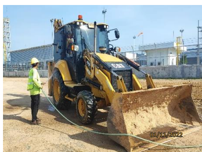
รูปที่ 2-9 พนักงานทำความสะอาดเศษวัสดุหรือดินที่ร่วงหล่นบนถนน และล้อรถที่มีเศษดินโคลนติด ก่อนออกจากพื้นที่ก่อสร้าง
